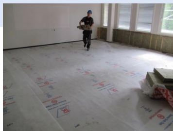
Beskyttelse av gulv under rehabilitering
