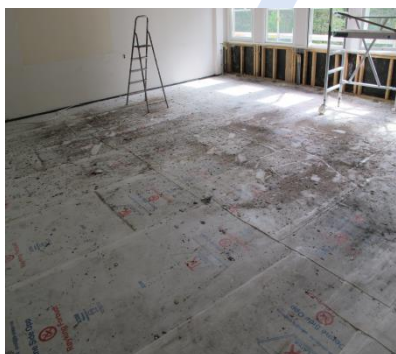
Beskyttelse av gulv ved rehabilitering
