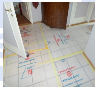
Beskyttelse av fliselagt gulv
